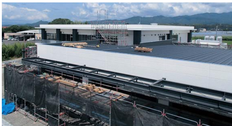
現在建設中の上球磨消防署新庁舎
