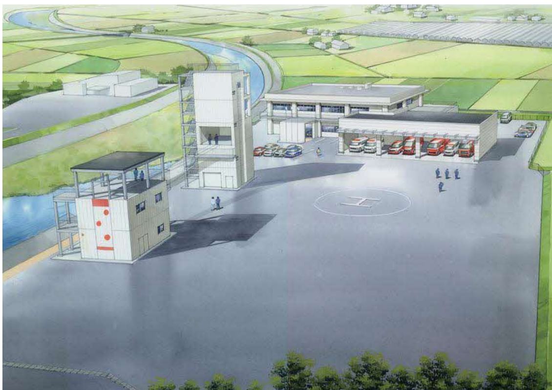
上球磨消防署新庁舎完成の全体イメージ
