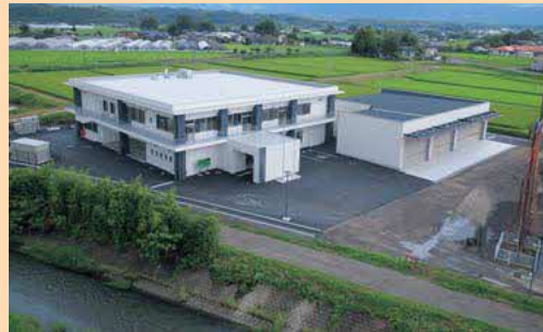
上球磨消防署新庁舎の外観
