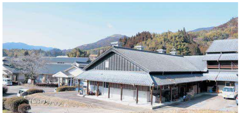
改修予定の山の幸館西側加工施設
