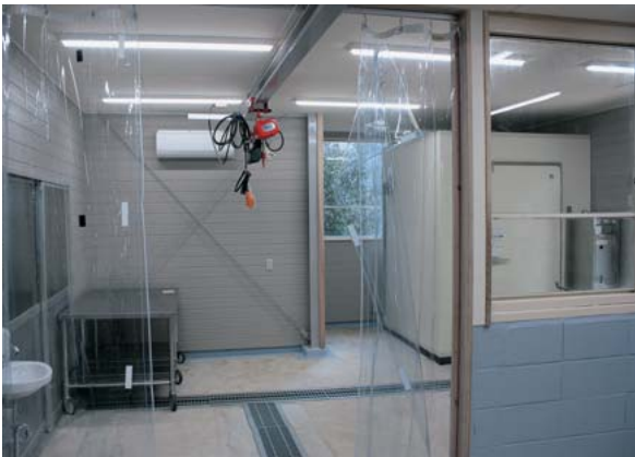
ジビエ処理加工施設
