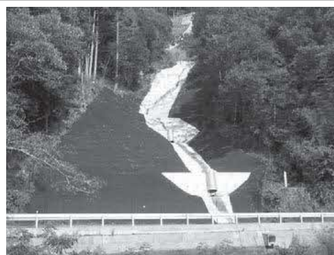
③ 小樫 山腹工完成後
