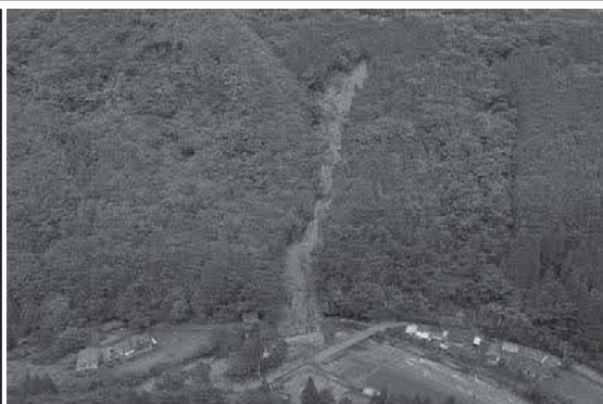
③ 小樫 山腹工着工前
