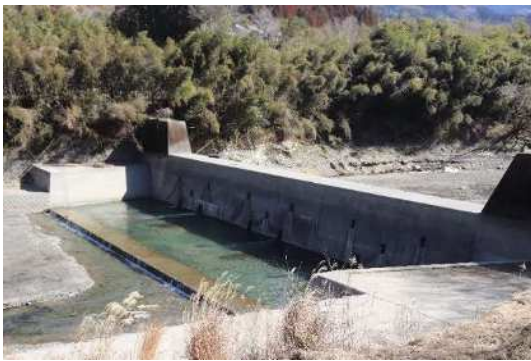
③-1 土砂搬出工事を終えた市房第2貯砂ダム(湯山川) (撮影:令和8年2月20日)
