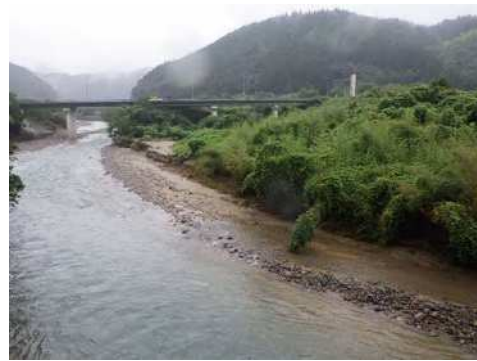
③-2 市房第2貯砂ダムから100mほど上流の土砂の様子(湯山川) (撮影:令和2年7月16日)
