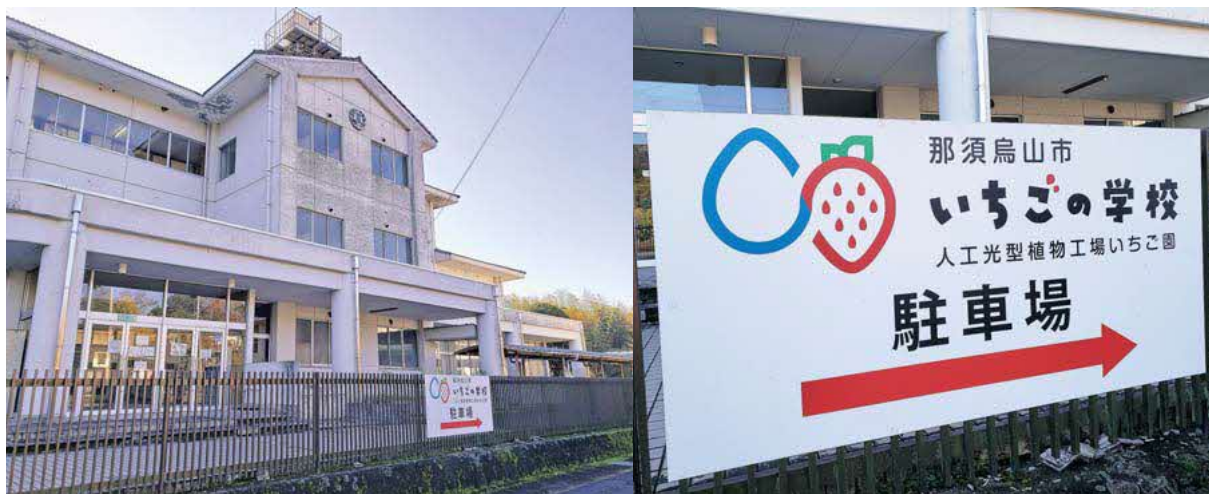
廃校を活用した「いちごの学校」(旧向田小学校外観)
