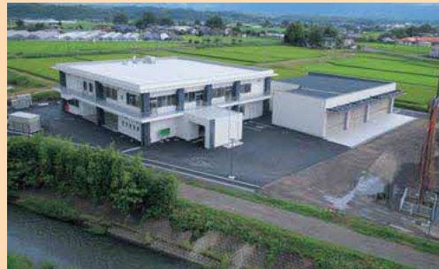
上球磨消防署新庁舎の外観
