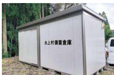
役場南側にある備蓄倉庫
